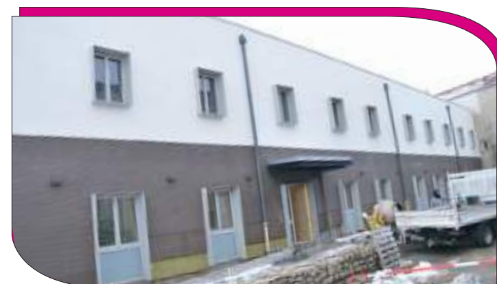
... En cours de travaux
