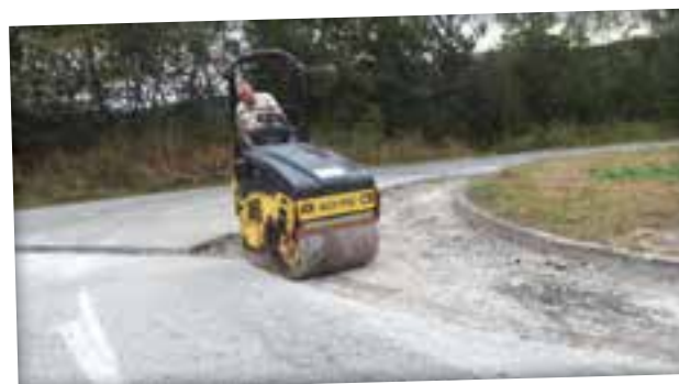
Entretien des voiries et des réseaux d'assainissement
