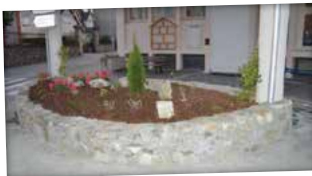
Construction d'un massif devant la médiathèque
