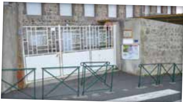
Réfection de la peinture des barrières devant l'école Don Bosco
