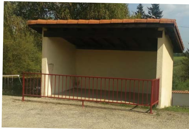
Une barrière a été posée par nos agents à l'abribus du Sarret afin de prévenir toute chute sur la chaussée au passage du bus scolaire.
