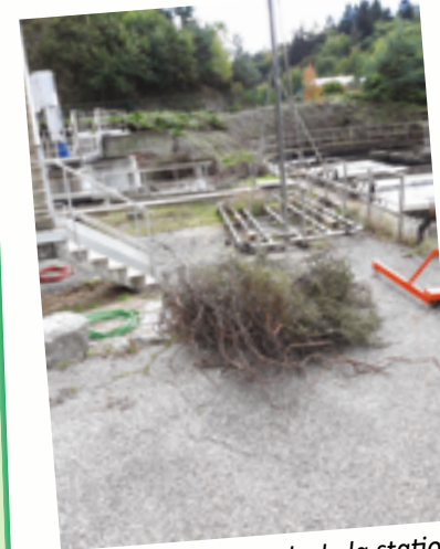
Entretien des abords de la station d'épuration de Roche-Moulin
