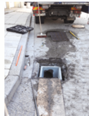
Réparation des réseaux d'assainissement
