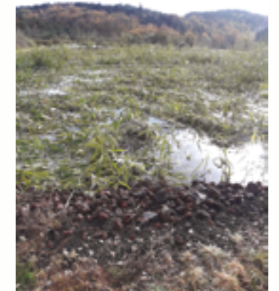
Faucardage des roseaux à la station d'épuration de type plantée de roseaux à Malmont
