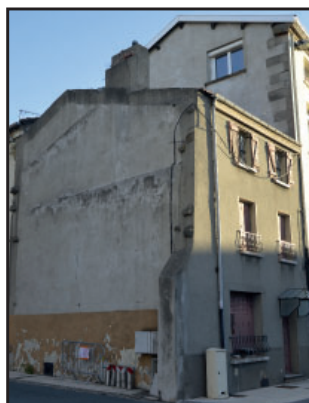
Isolation et enduit sur partie haute des murs extérieurs
